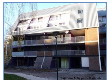
Immeuble Actis rénové donnant sur le parc.
